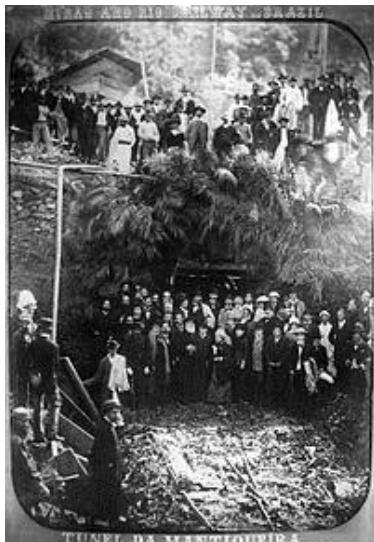
Figura 1 - Visita do imperador Dom Pedro II às obras do Túnel da Mantiqueira em 1882. Esta fotografia foi tirada em frente à entrada cruzeirense do túnel.
